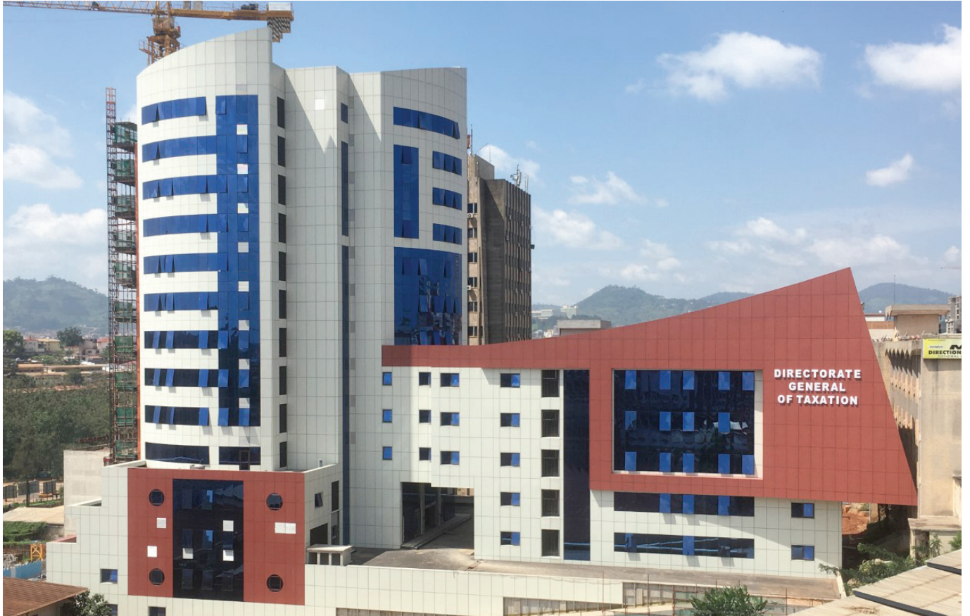
Nouveau bâtiment de la Direction Générale des Impôts en construction à Yaoundé
